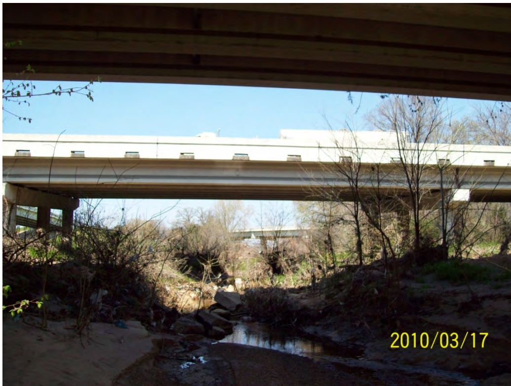
STR13 – downstream face
