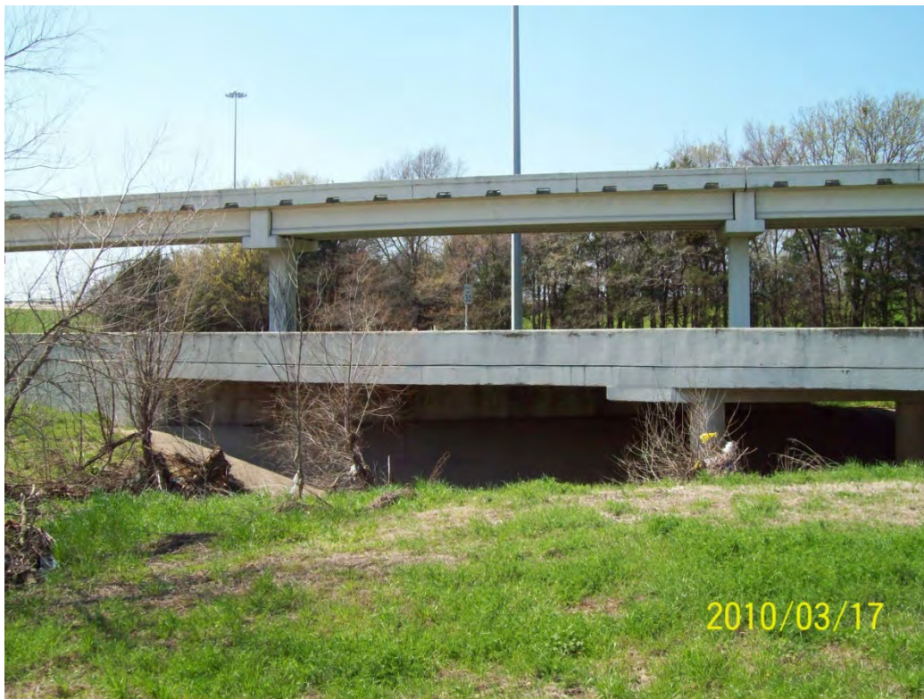
STR11 – downstream face
