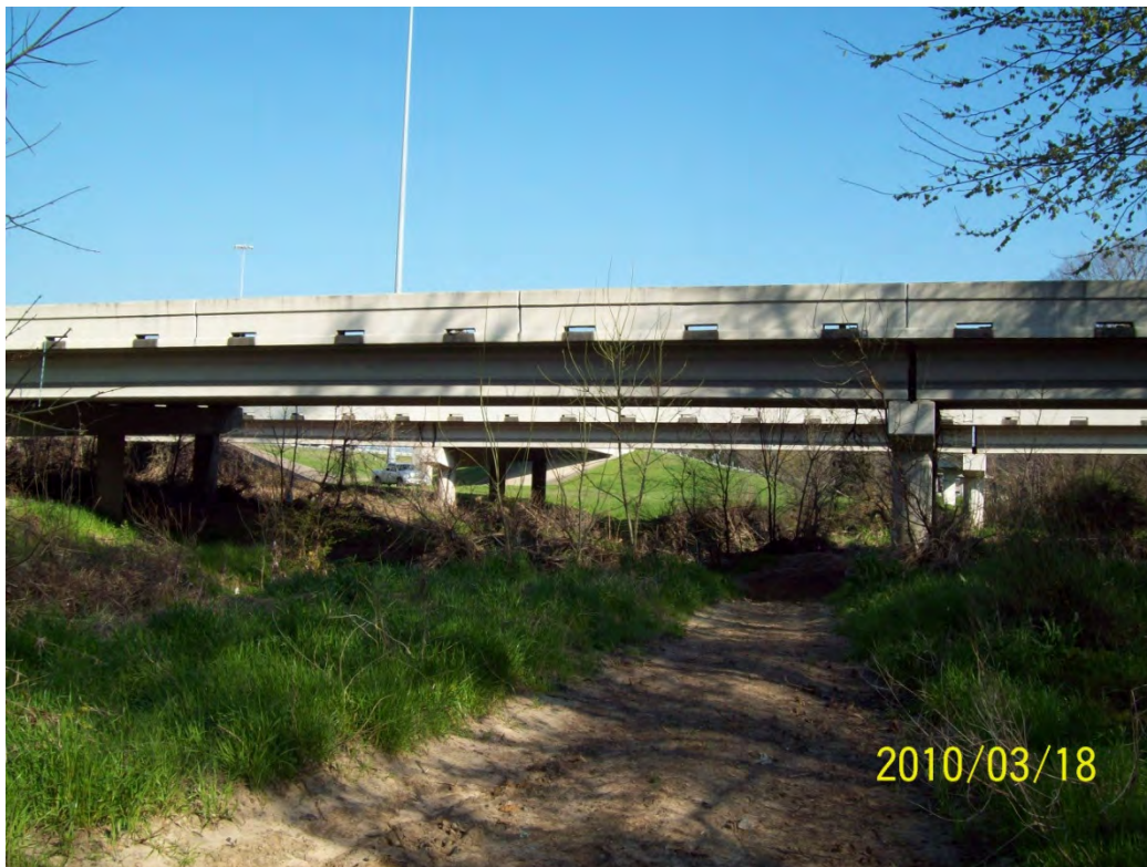
STR14 – downstream face
